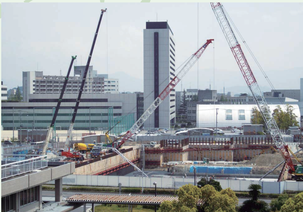
新診療棟の新築工事
