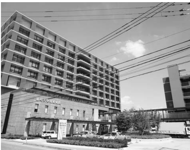
福岡大学筑紫病院 右が完成した立体駐車場
